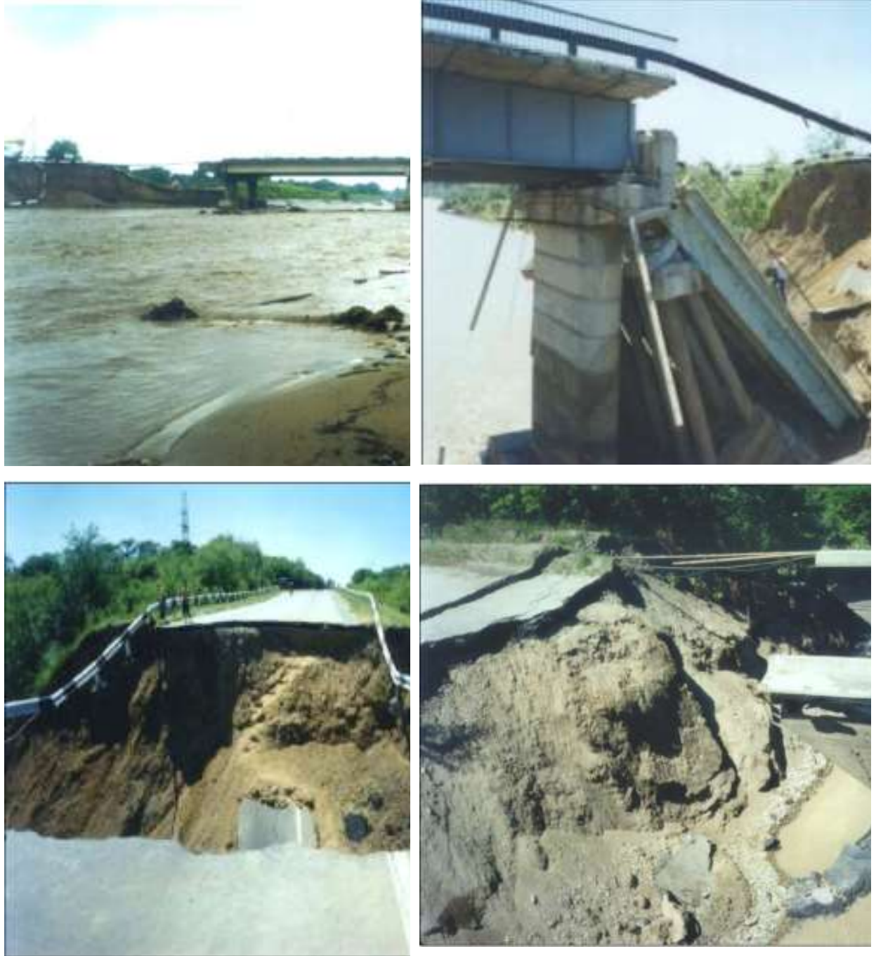
Рис.1. Разрушение насыпи перед береговой опорой
